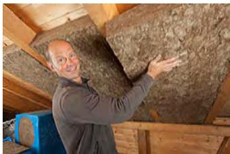
Pannello isolante elastico disponibile in varie larghezze con zona di deformazione integrata sul lato longitudinale. Impiego nell'edilizia in legno con interessi compresi fra 460 e 700 mm.
