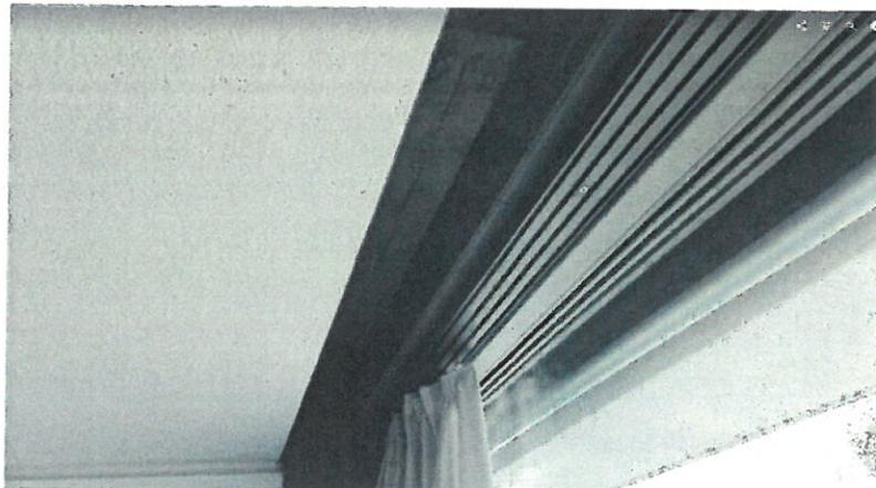
Foto 2 – Canale di ventilazione negli uffici, ricavato da un risparmio della soletta, con elemento di chiusura inferiore rimosso
