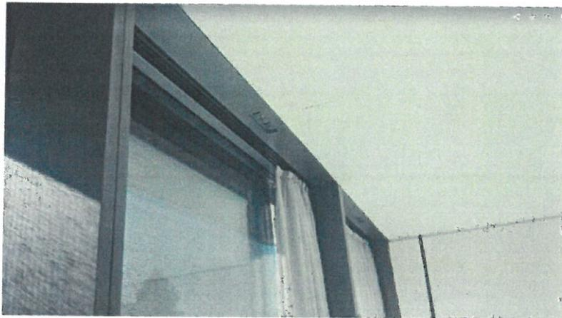
Foto 1 – Canale di ventilazione negli uffici, ricavato da un risparmio della soletta, con elemento di chiusura inferiore
